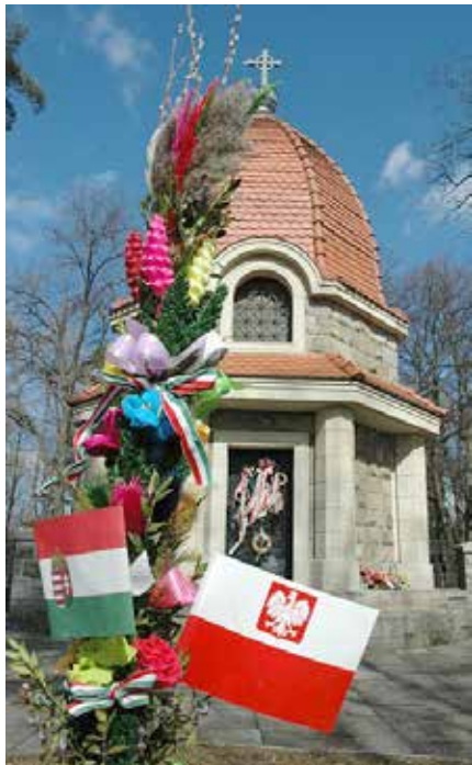
Vitéz Muhr Ottmárnak, a 9. Nádasdy-huszárezred parancsnokának, a limanovai csata hősi halottjának mauzóleuma, a Limanowa melletti Jabloniec magaslaton található, a 368-as számú haditemetőben.
